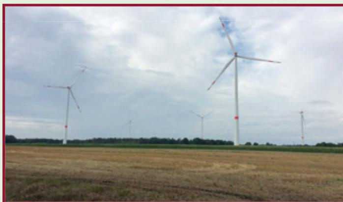
sogenannte „Null-Schattenregelung“. Diese sorgt dafür, dass die Windräder bei Schattenschlag sofort abgeschaltet werden.
